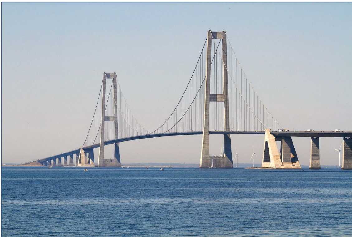
Storebæltsbroens to midterste bærekabler hænger tilnærmelsesvist i en parabelbue
